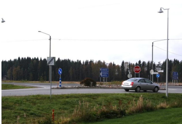
Murickkorsningen vid riksväg 13.
